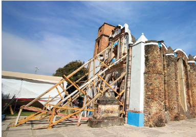
Restauración de inmuebles
